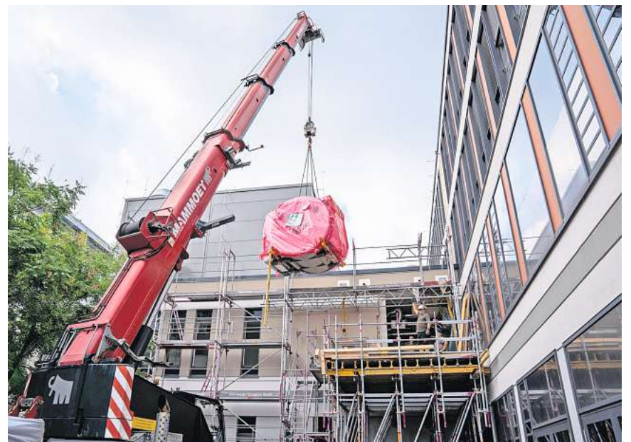
Eine Szene vom Baugeschehen Ende Juni: Nur über einen Durchbruch in der Außenwand konnte der sieben Tonnen schwere neue MRT an seinen damals noch zukünftigen „Arbeitsplatz“ eingebracht werden. Fotos: Stefan Straube (2), Hagen Deichsel
